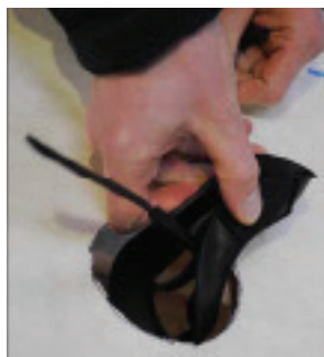
Pres underdelen sammen, og før den ind på bagsiden af undertaget.
