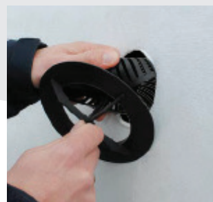
Pres undertagsventilen sammen, så undertaget er placeret mellem dæksel og underdel.
