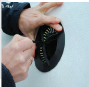
Dæksel trækkes stramt ned til undertaget indefra.
