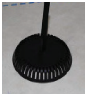
Undertagsventilen er nu monteret.
